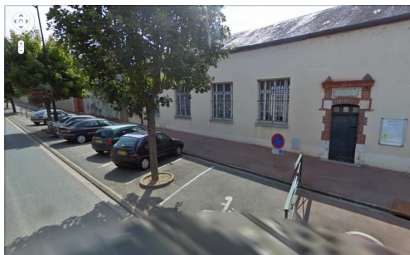
Centre de Formation Sainte Anne Lieu de formation : 5 boulevard Loreau
